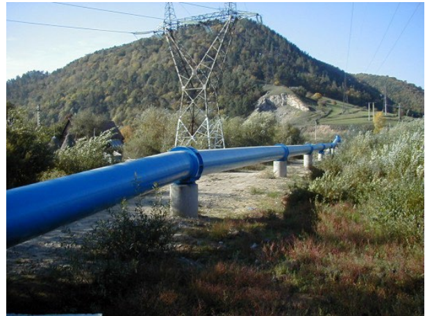
Figura 16. Magistrală de apă Tarnița - Sălaj (Someș C. d., 2018)
