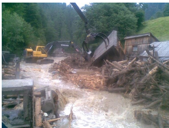
Fig. 18 Dégagement du matériel ligneux transporté par la fange à Valea Vinului
