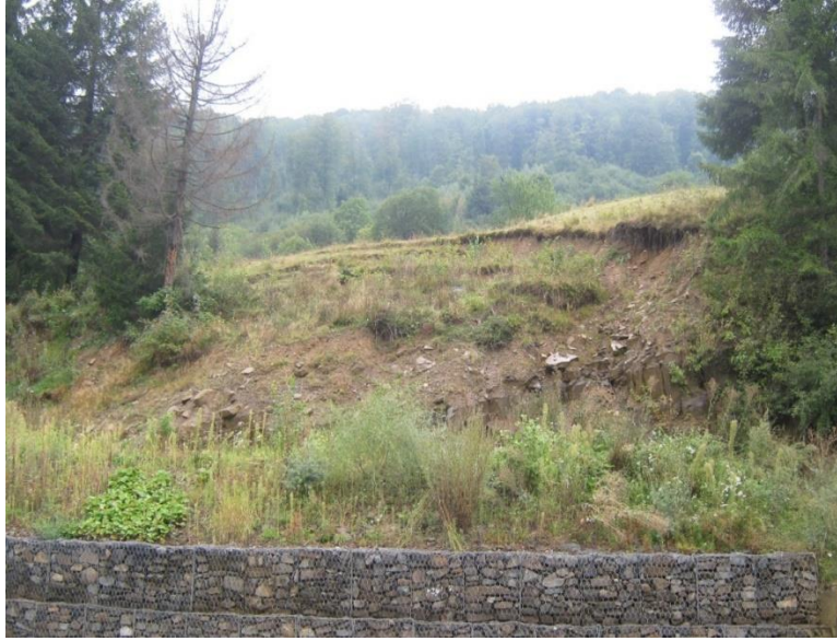
Fig. 6 Glissement de terrain auprès de la localité Mureșenii Bârgăului
