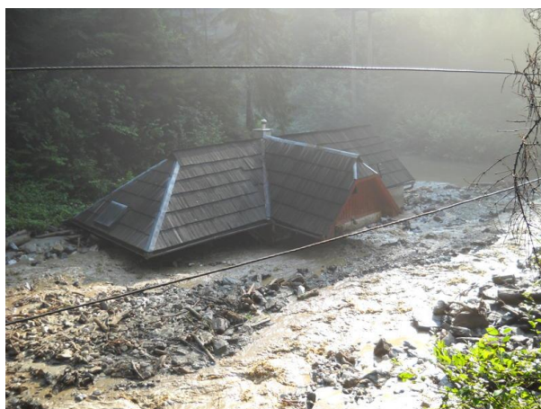
Fig. 16 Habitation après la fange enterrée par les alluvions entraînées par le ruisseau Băilor (photo: www.bistriteanul.ro )
