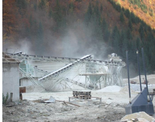
Fig. 24 Fabrique de terrassit sur la Vallée de l'Anieș
