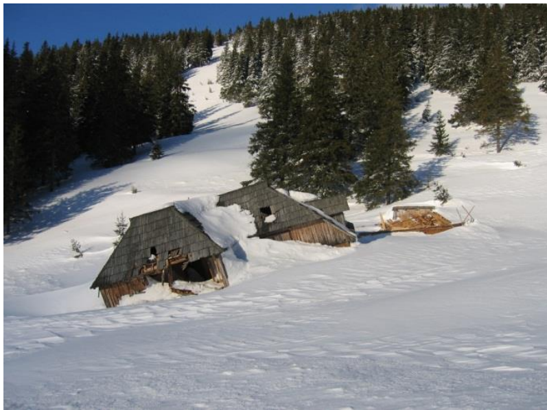
Fig. 14 Chalet de Bistricior, détruite par l'avalanche (source: www.carpati.org )
