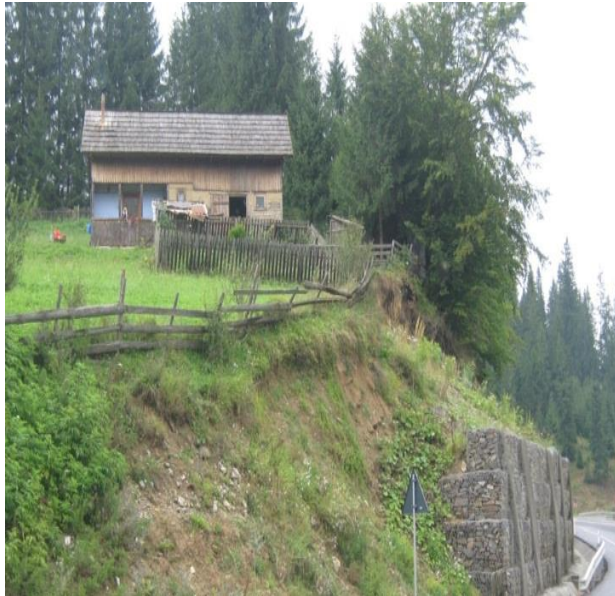
Fig. 4 Danger d'éboulement Piatra Fântânele
