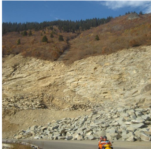
Fig. 5 Écroulement à Măgura Ilvei
