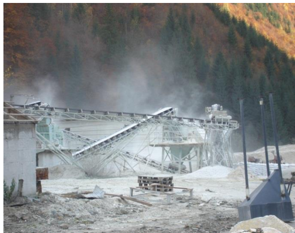
Fig. 24 Fabrica de terasit de pe Valea Anieșului
