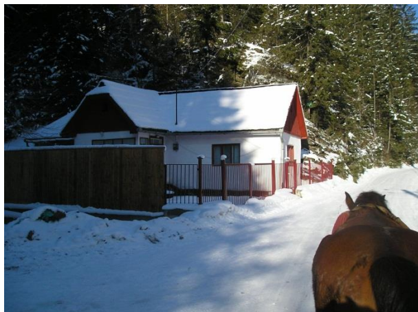
Fig. 15 Locuință înainte de viitură
