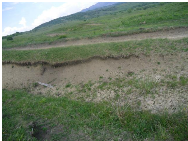
Fig. 9 Tăiere și eroziune în Poiana lui Tămaș
