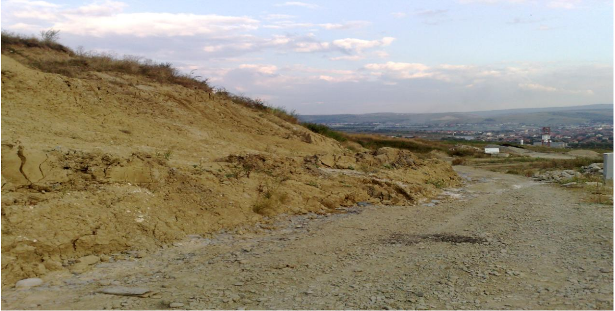
Fig. 3. Alunecare de teren provocata de extinderea drumului, ( versantul sudic al dealului Chinteni )
