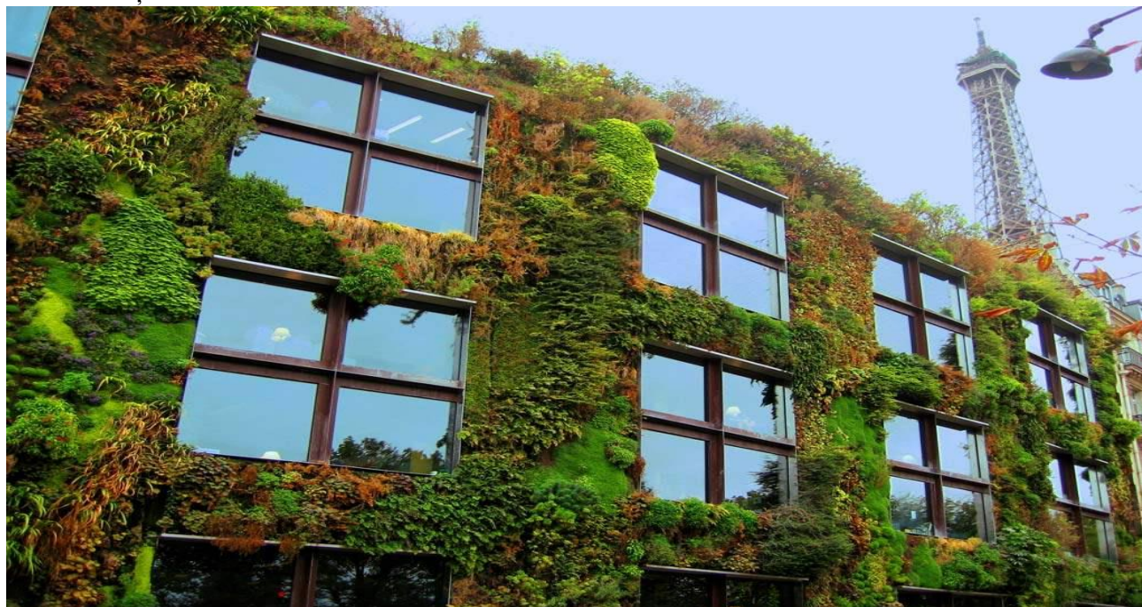
Figura 6.2 Grădină verticală proiectată de Patrick Blanc la Muzeul Quai De Branly, Paris. Sursa: http://www.i.pinimg.com
