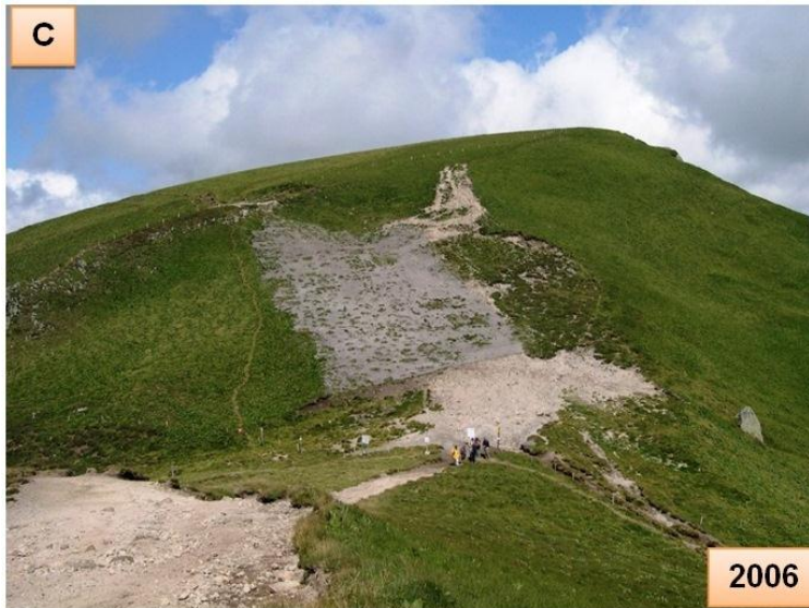
Figura 122: Sectorul reabilitat de pe versantul estic al vârfului Puy Ferrand; A – fotografie realizată înainte de demararea lucrărilor; (foto: Philippe BOICHUT, PNRVA, 15. 10. 2001); B – fotografie realizată în timpul lucrărilor (foto: Philippe BOICHUT, PNRVA, 23. 09. 2005); C - fotografie realizată după un an de la finalizarea lucrărilor (foto: Bernard PAUTY, PNRVA 08. 10. 2006); D - fotografie realizată după doi ani de la finalizarea lucrărilor (foto: Olimpiu POP, 08. 09. 2008).
