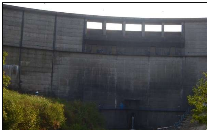
Barajul acumulării hidrotehnice Cinciș-Cerna
