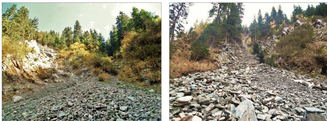
Fig. 41. Acumularea depozitelor rezultate din dezagregarea rocilor la baza versanților aferenți canalului de scurgere
