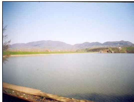
Lacul de acumulare – vedere spre baraj
