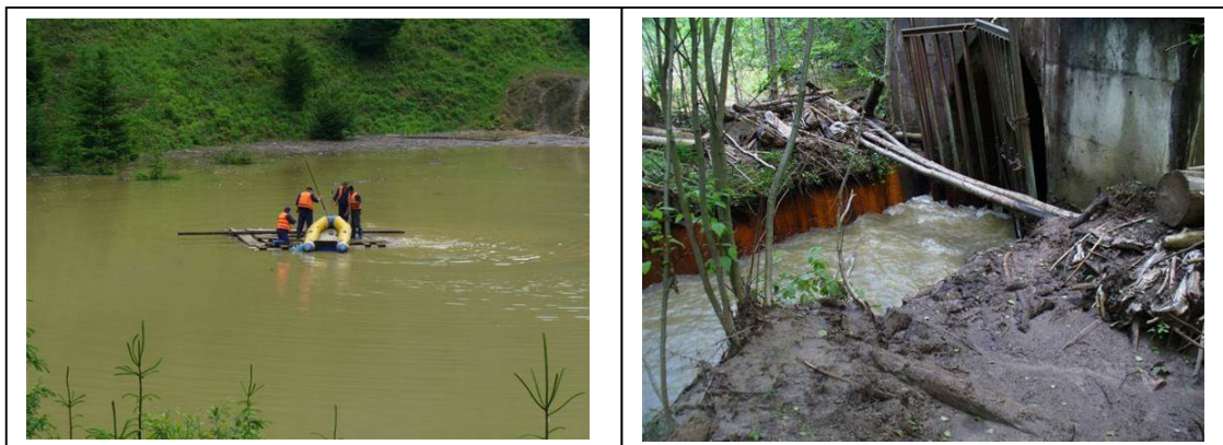
Fig. 11 Lacul temporar format deasupra iazului punând în pericol locuitorii din aval și turiștii din localitatea Ostra și Fig. 12. Detaliu al tunelului de deviație al torentului din zona amonte a iazului de decantare, parțial blocat de nămol și plutitori
