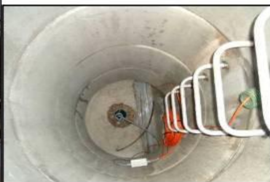
Fig.6.1. Panou de control Fig.6.2. Cămin de vizitare dren sifon cu senzor
