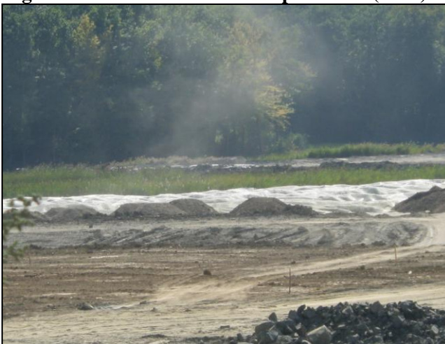
Fig. 79: Aplicarea geomembranei pe plaja iazului (2013)
