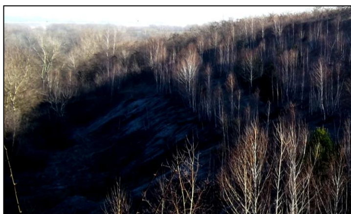
Fig. 61: Eroziune areolară pe Iazul Lunca Mureșului
