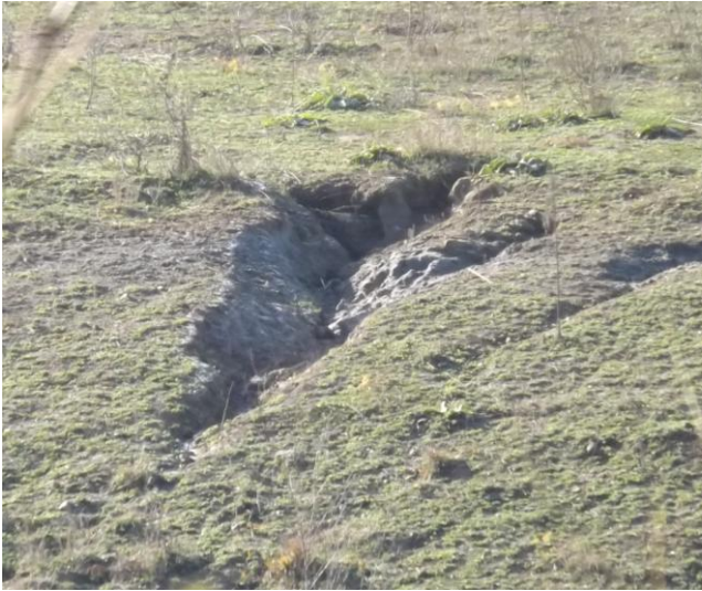
Fig. 62: Rigolă pe lazul Valea Devei
