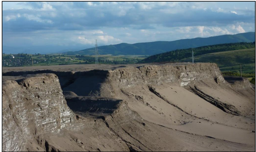
Fig 28: Iazul de decantare Nr. 1 Valea Cărbunelui Teliuc
