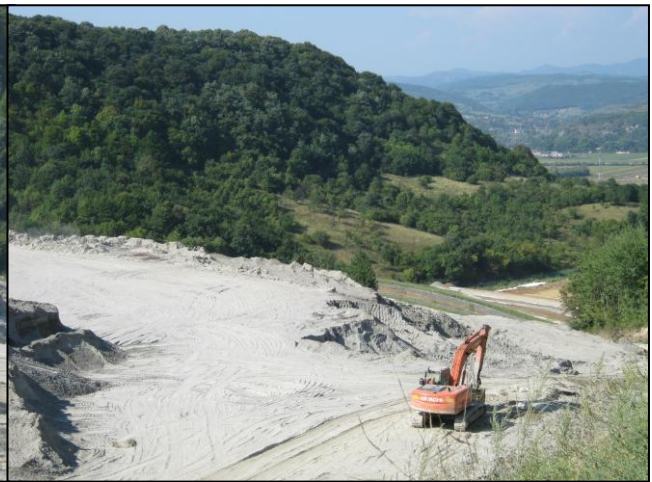
Fig. 78: Nivelarea sterilului cu utilaje (2011)
