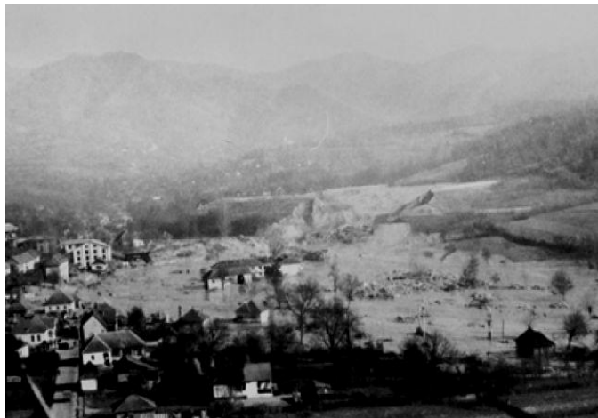
Fig. 55: Ruperea digului iazului de decantare de la Certeju de Sus (sursa foto: www.adevărul).
