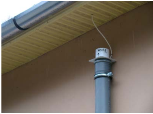
Fig.3.3. Ventilatorul electric din capătul superior al tubului PVC (stânga) și ventilatorul electric nr. 4 instalat în podul casei și conectat la colectorul de radon instalat în dormitorul 2 (dreapta) (original).
