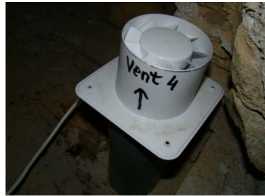
Fig.3.3. Ventilatorul electric din capătul superior al tubului PVC (stânga) și ventilatorul electric nr. 4 instalat în podul casei și conectat la colectorul de radon instalat în dormitorul 2 (dreapta) (original).
