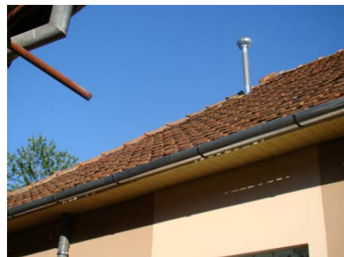
Fig. 3.4. Cuplarea celor doi colectori de Rn (1 și 2) în podul casei, care se continuă cu ventilatorul electric în podul casei și către un cap eolian de extracție spre acoperișul casei (original).
