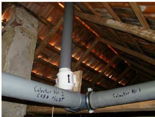
Fig. 3.4. Cuplarea celor doi colectori de Rn (1 și 2) în podul casei, care se continuă cu ventilatorul electric în podul casei și către un cap eolian de extracție spre acoperișul casei (original).
