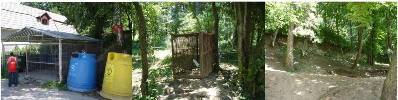
a. Împrejmuire din beton și fier la tomberoate. B. Cușcă amplasată lângă gară pentru racolat urși. c. Lucrare de consolidare versant.
