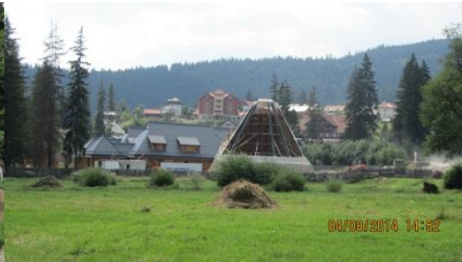
e. Centrul nou de tratament și wellness în construcție (surse: autorul).
