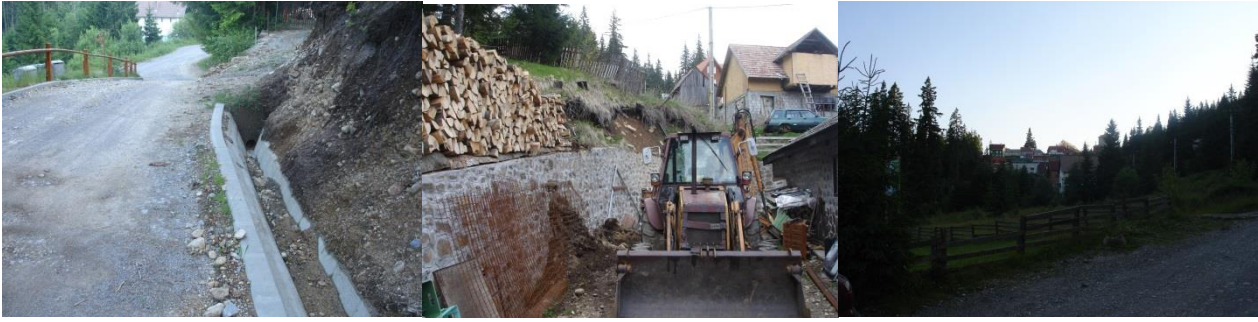
Figura 13 a. Modernizarea infrastructurii edilitare. b. consolidarea versanților cu pereți de beton și piatră c. Model de împrejmuire simplă.
