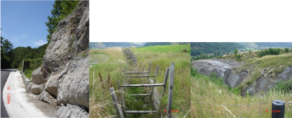
g. Lucrare de consolidare a versanților pe DN13B h. Lucrări de drenare a apei pe Muntele de Sare i. Torrent astupat cu material de la Salrom. (surse: autorul).
